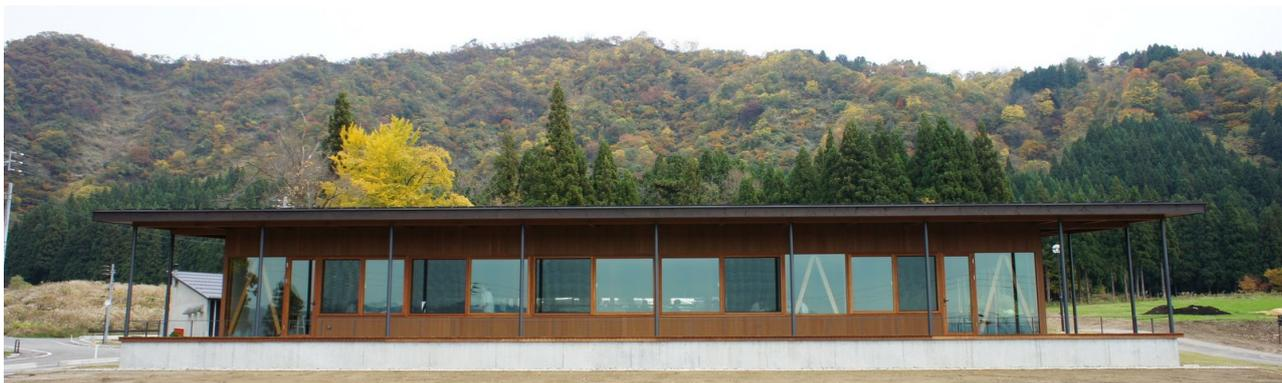
全面開口の西面。3カ所でテックワン P3 プラスを用いたブレース構造が現しになっている
