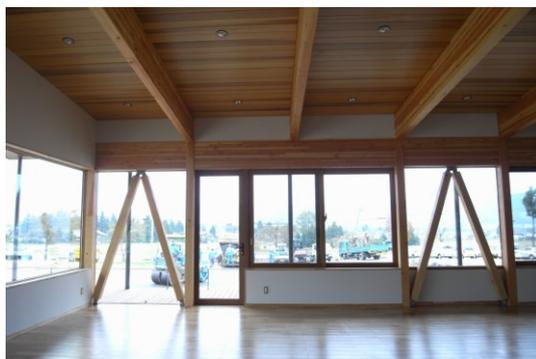
建物の内観。7.58m のスパンに架かる大梁の断面は 120mm×660mm。ブレース構面は壁倍率 10 倍相当の高耐力を有する
