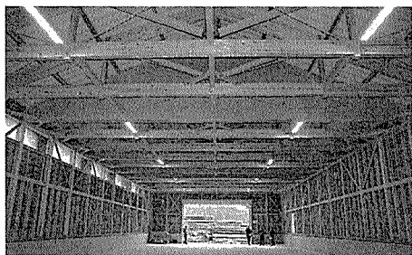
6、4、4桁の梁材等で13桁のトラスを組んで建てられた
