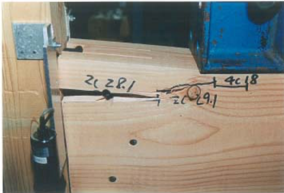
写真-4 破壊状況
