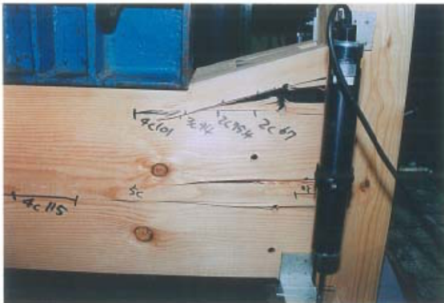
写真-2 破壊状況
