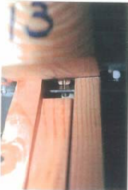
写真-9 破壊状況
