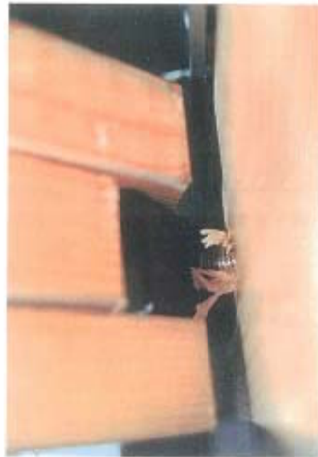
写真-10 破壊状況
