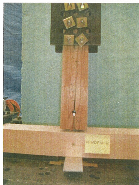
写真-4 破壊状況
