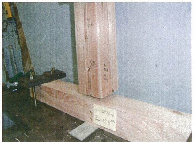
写真-6 破壊状況
