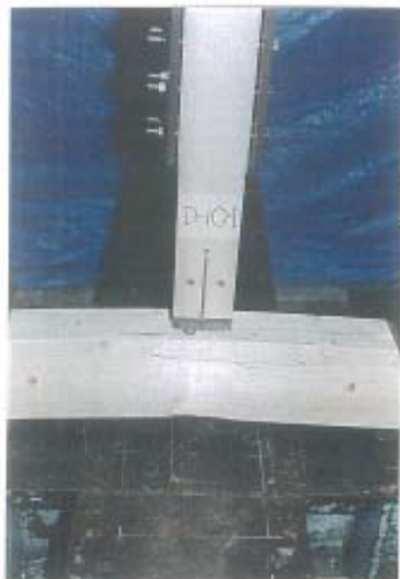
写真-1 破壊状況 試験体記号: DH0-1 最大荷重: 95.2kN 梁の割れ
