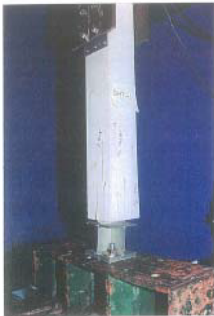
写真-1 破壊状況
